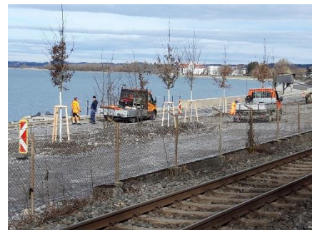
Die noch im Bau befindliche Copacabana!
